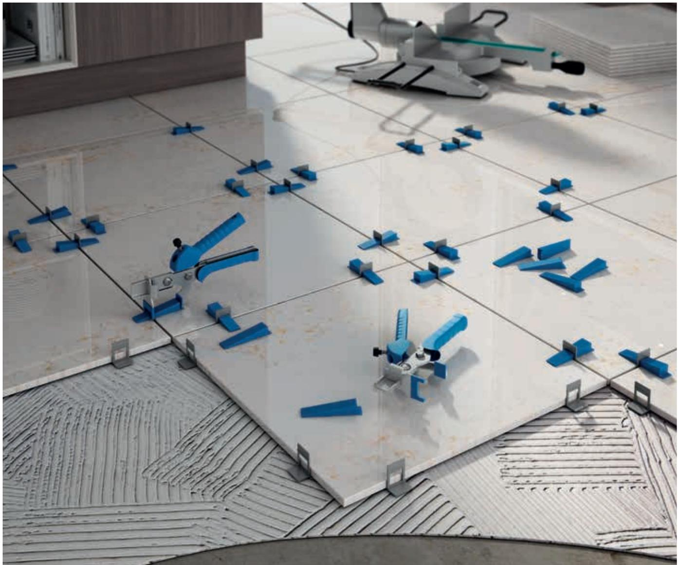
PIEZAS SISTEMA DE NIVELACIÓN - LEVELLING SYSTEM PIECES
