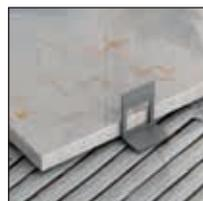
**2.** Insertar la cuña en el clip ajustándola con la mano. Insert the wedge in the clip adjusting by hand.
